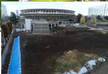
2022年12月。施工開始時、多少の段差を残して、地表があらわに。
